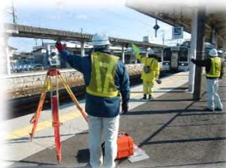
【常磐線 石岡駅構内 線路測量】
