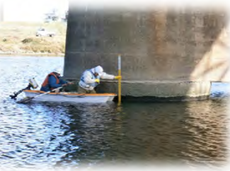
【横須賀線 多摩川橋梁河床調査】
