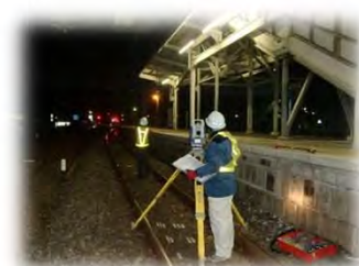
【水戸線 川島駅 駅構内測量】
