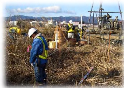
【常磐線 富岡駅構内 地質調査】
