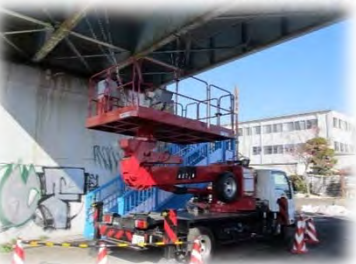
【高萩市 高萩陸橋 耐荷力調査(ひずみ計)補強設計】
