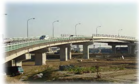
【常磐線 草野跨線橋 地質調査】
