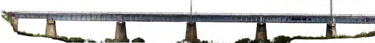
【東日本大震災被災JR橋梁点群データ】
